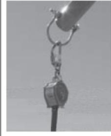
**Figura 7: Punto de anclaje de acceso y salida de la escalera**
